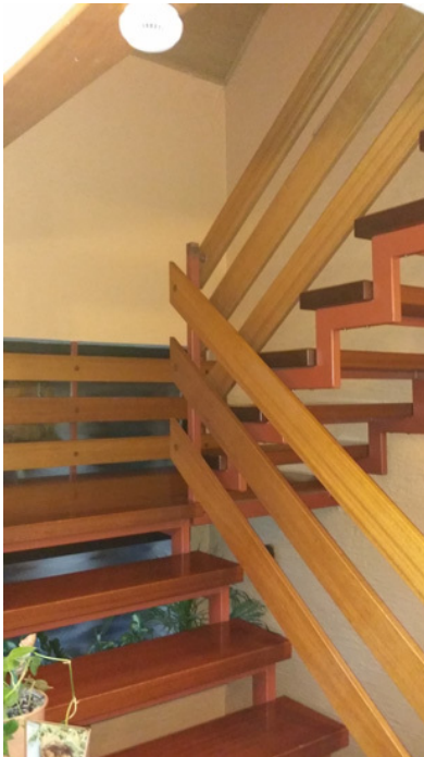
Abb. 1: Notwendige Treppe ohne Treppenraum
