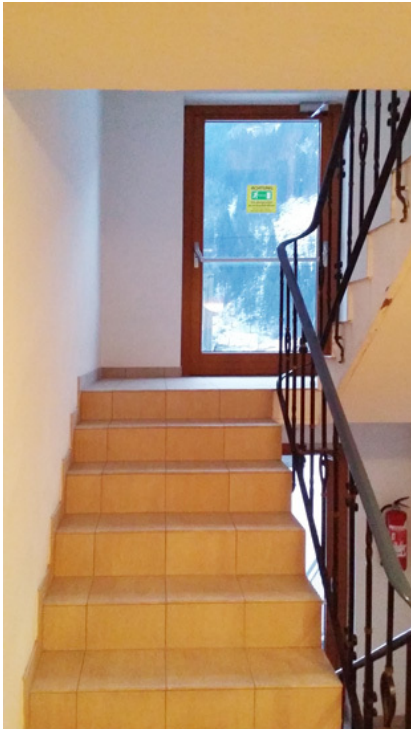
Abb. 5: Treppe in einem Mehrfamilienhaus
